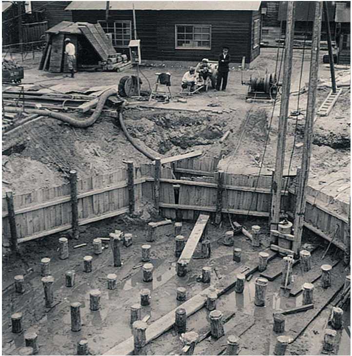
防塵煙突用杭打工事(昭和29年)
