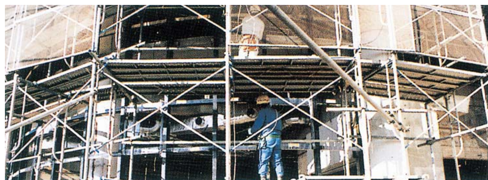
ALC施工現場
