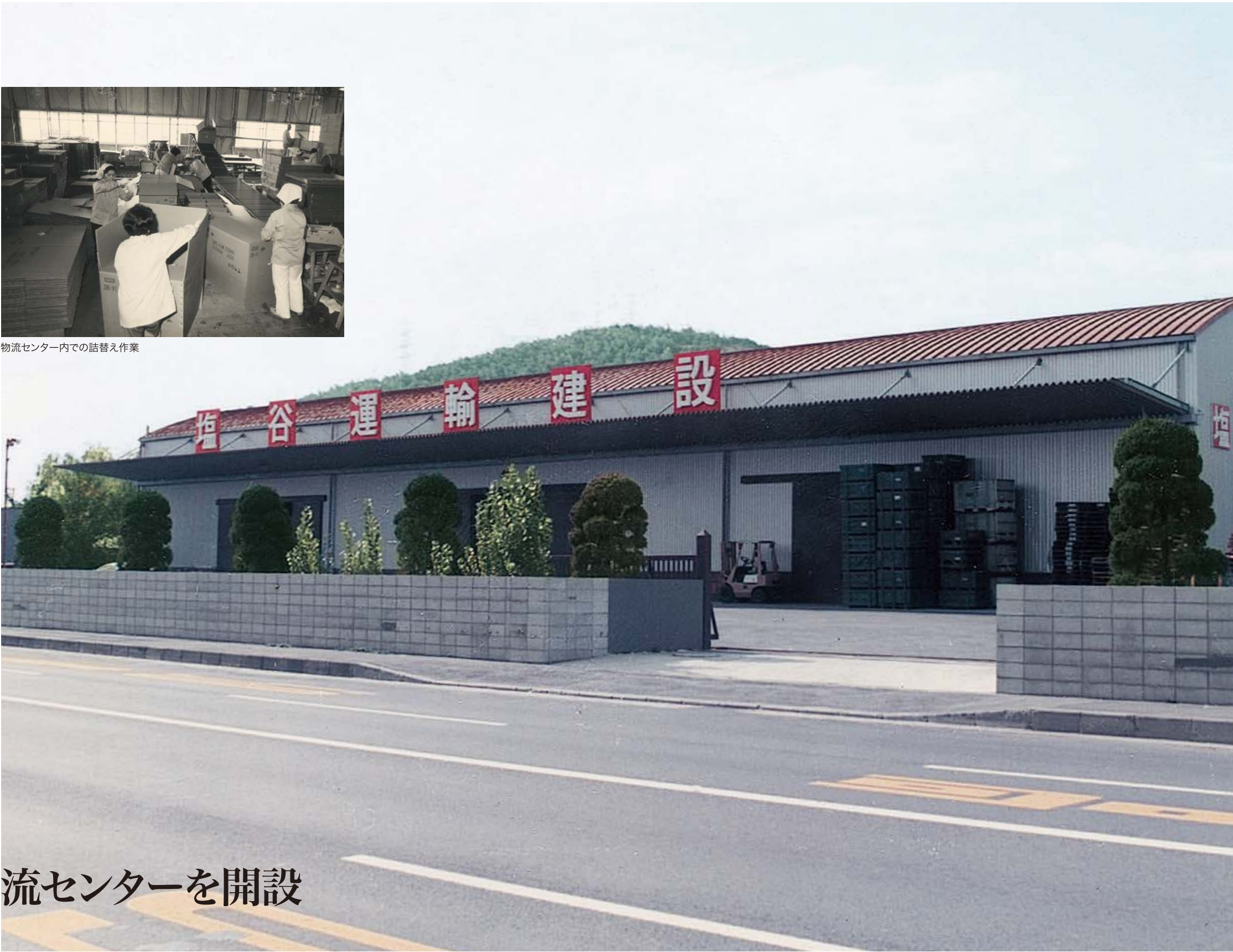
24時間体制（3交代勤務）で稼働した高槻物流センター
